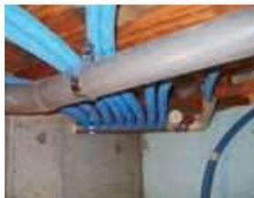
架橋ポリブデン管によるヘッダー方式配管例
